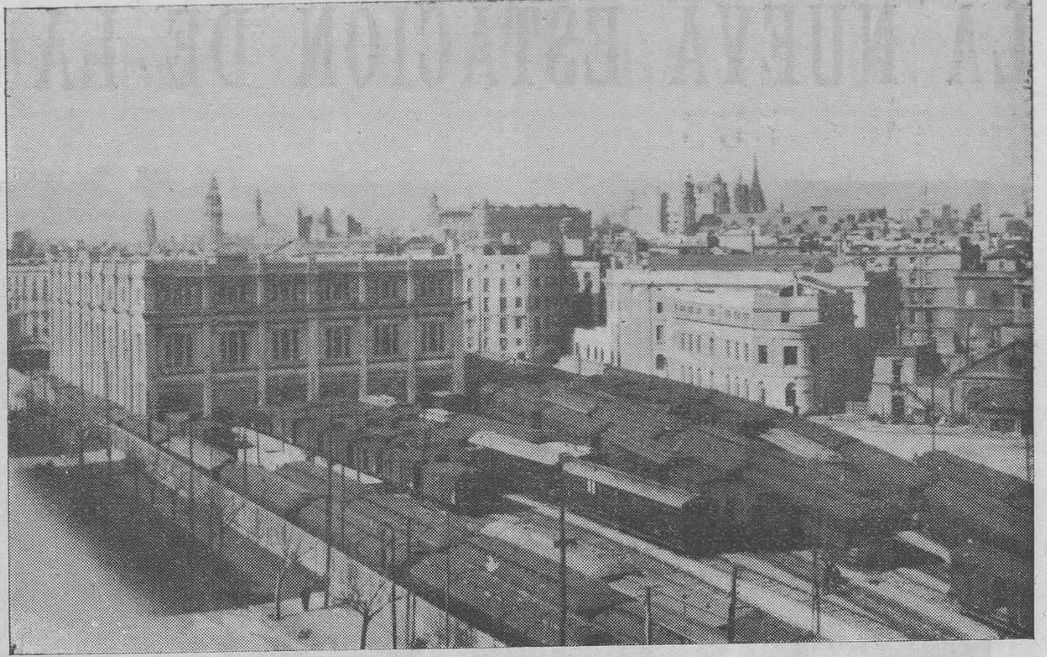
La nueva estación de M. Z. A. Vista parcial.
