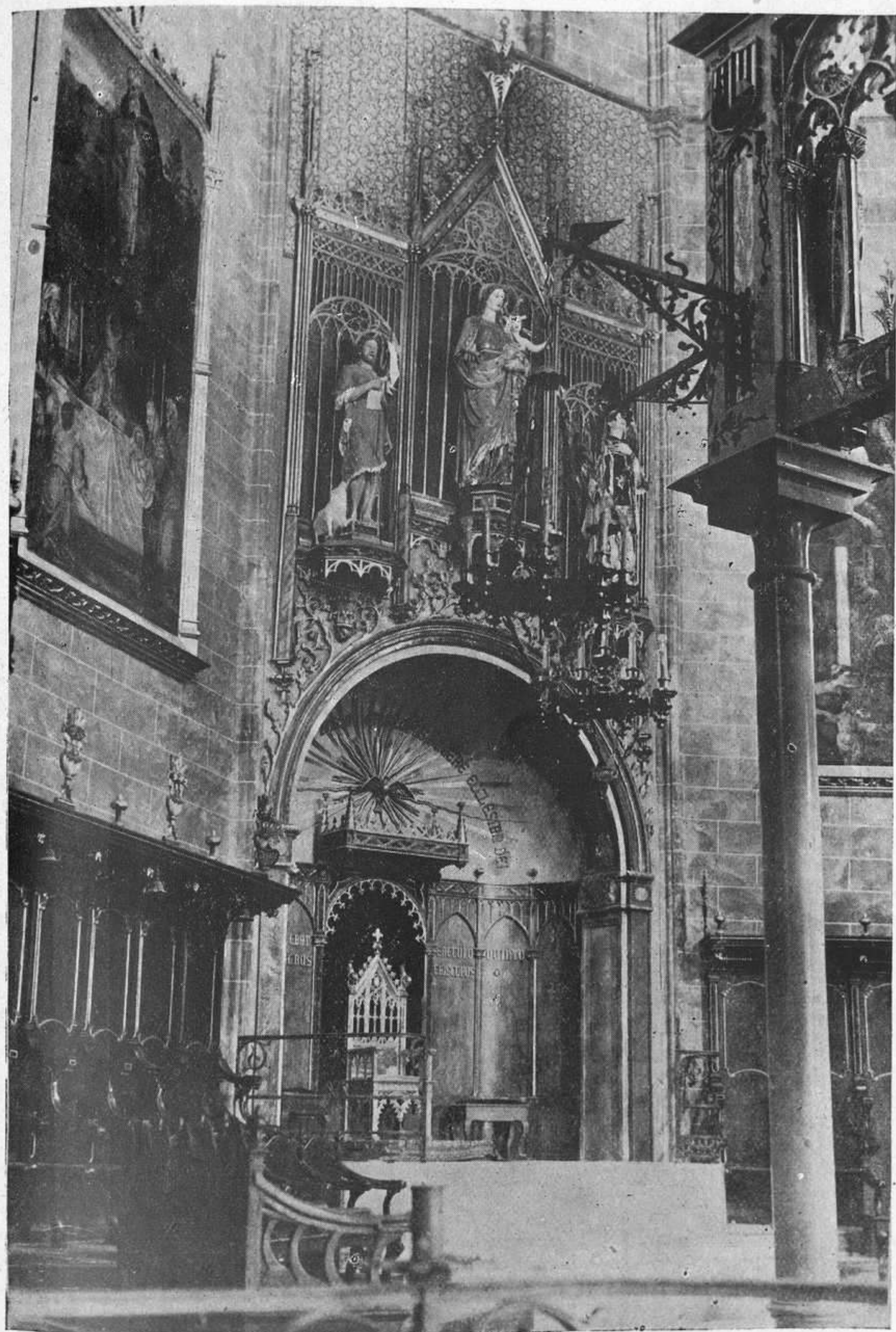
VISTA DEL FONDO DEL ABSIDE CON LA CATEDRA INTERINA DE MADERA COLOCADA EN LA REFORMA DE 1941
