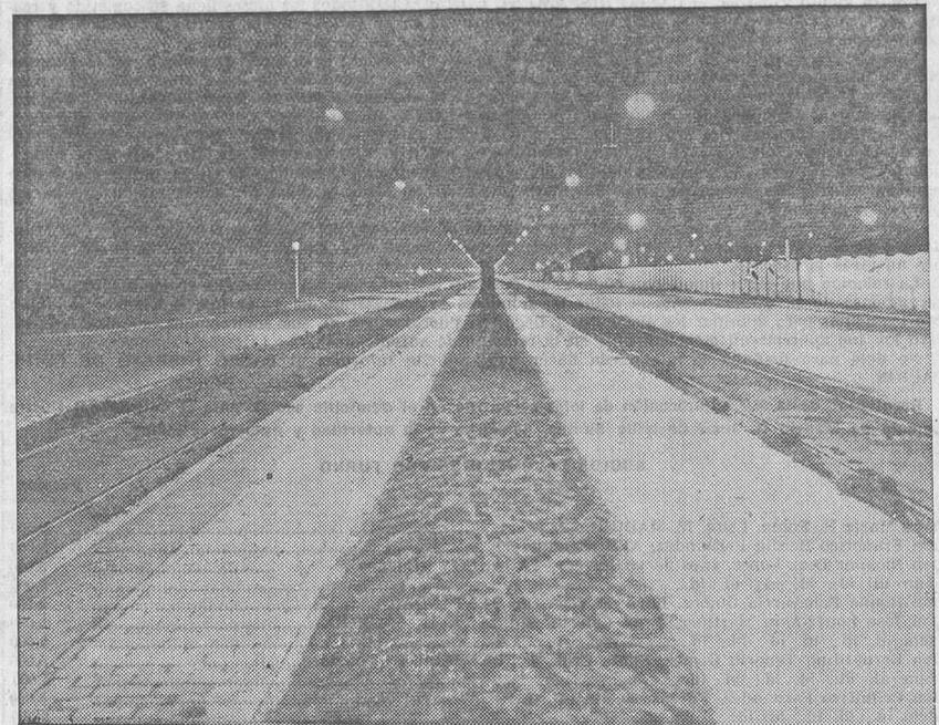
Acaba de inaugurarse la primera parte de la iluminación al sodio de la ruta Bruselas-Malinas-Amberes. La parte iluminada alcanza un trozo de unos cuatro kilómetros, comprendido entre Bruselas-Vilvorde. La instalación consta de 233 lámparas Philips al sodio, de una potencia de cien kilovatios
