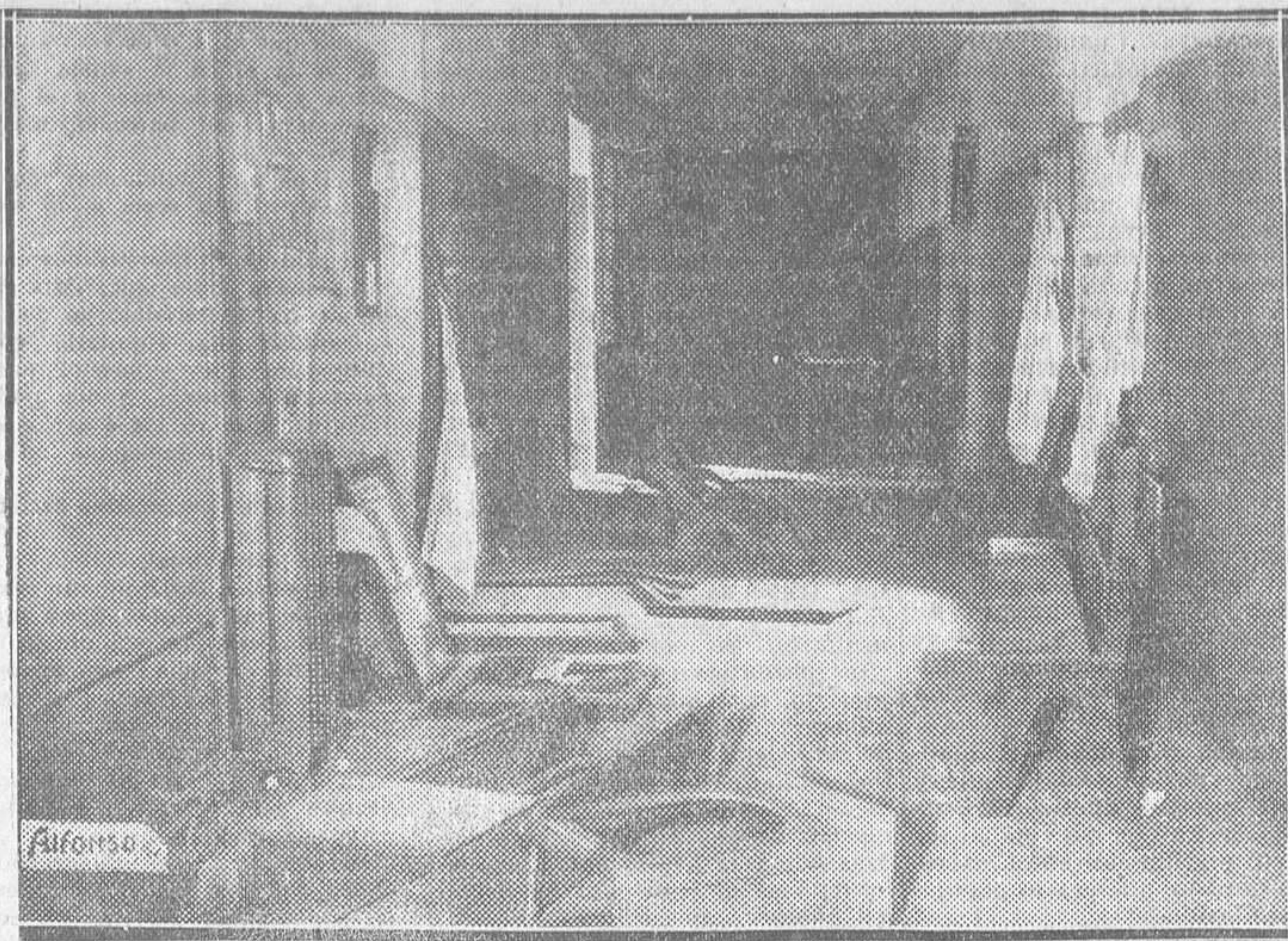
Destrozos causados ayer por los alumnos de aparejadores en la Escuela de Arquitectura (Fot. Alfonso.)
