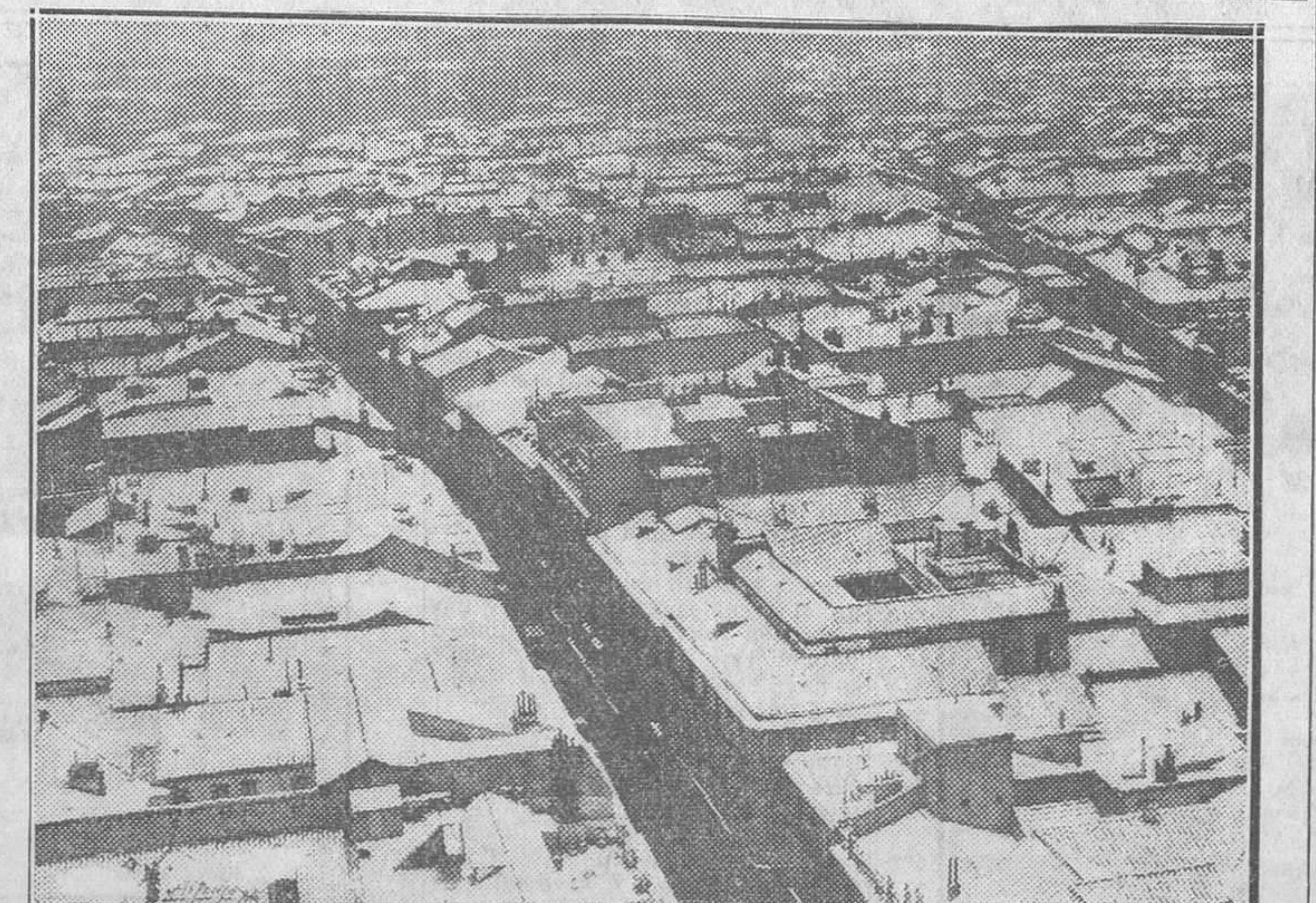
Aspecto que ofrecía ayer la parte alta de Madrid, tomada a vista de pájaro (Fot. Alfonso)
