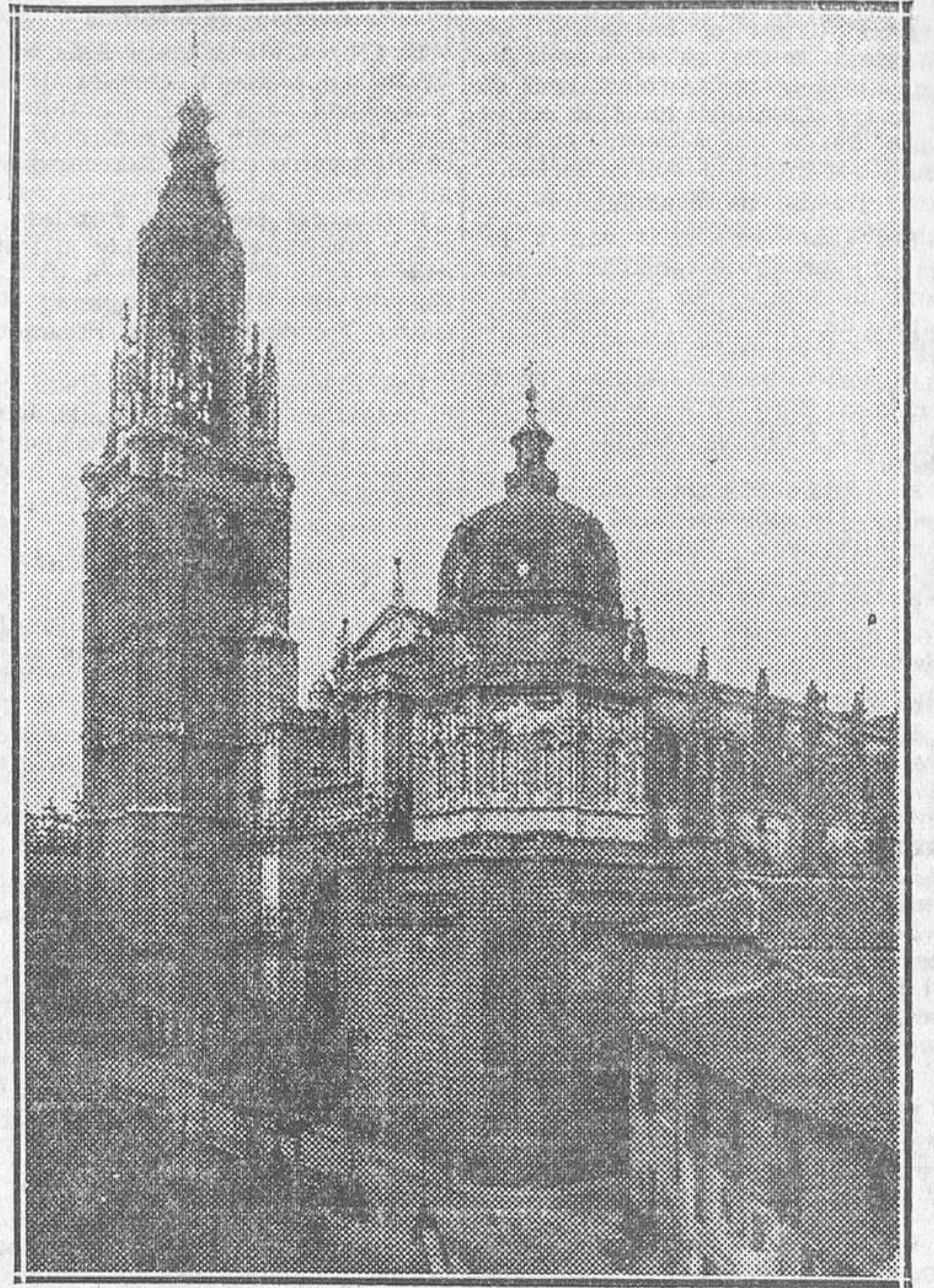
TOLEDO.—La Catedral: vista exterior de la capilla mozárabe y torre
