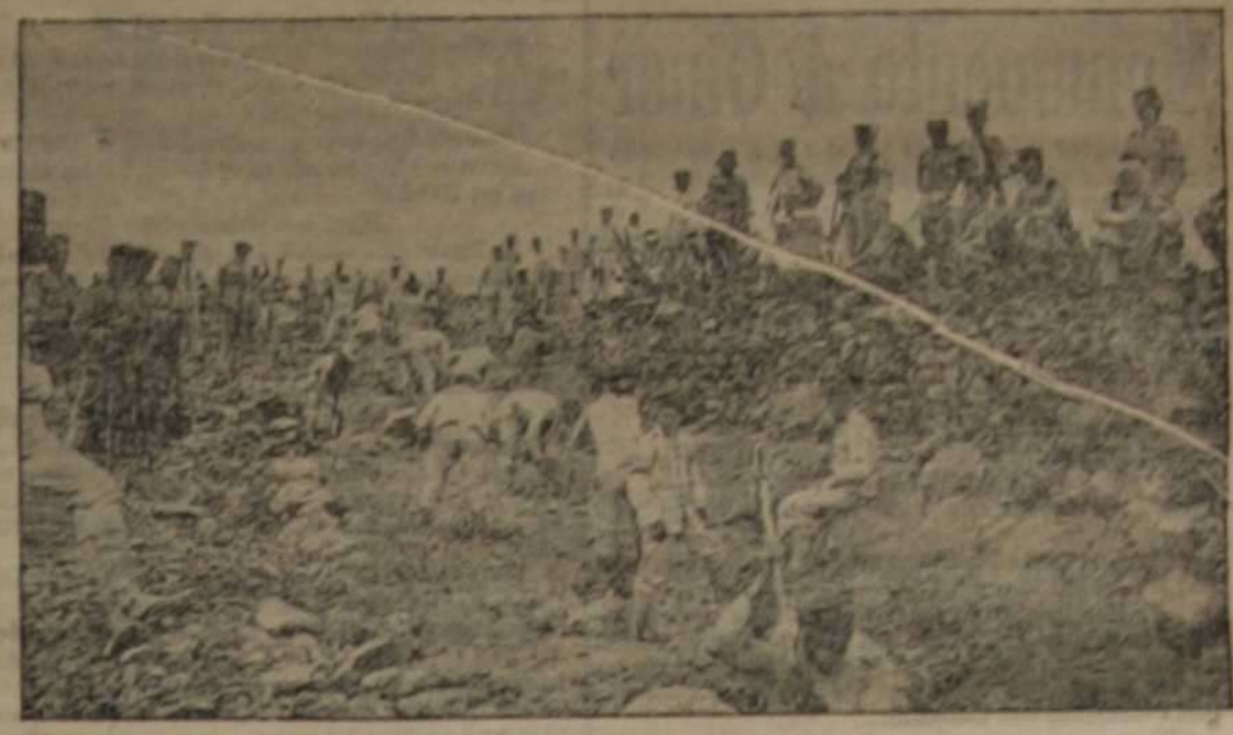
Fuerzas de infantería, construyendo obras de fortificación en Tebasit
