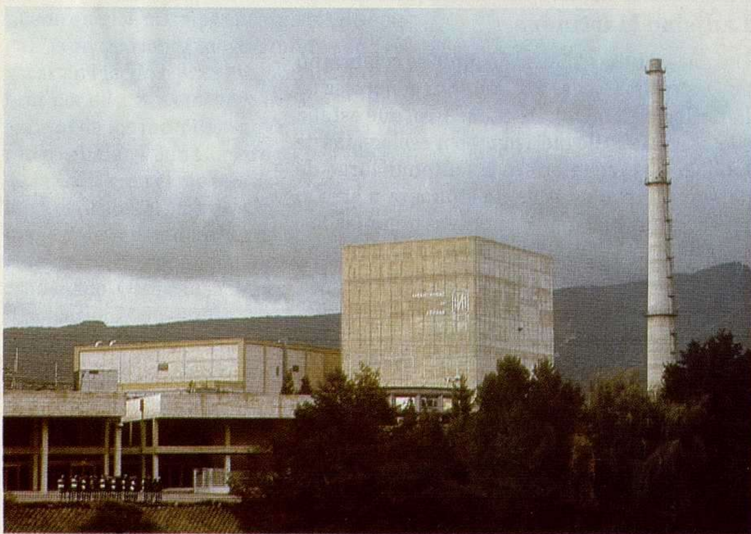
Garoña, una central con muchas grietas.
