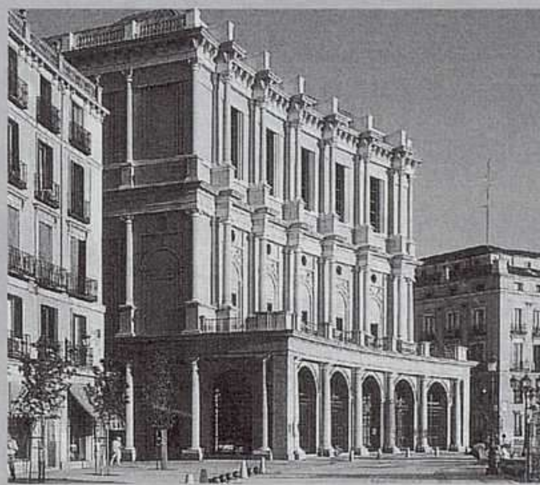
Fachada del Teatro Real
