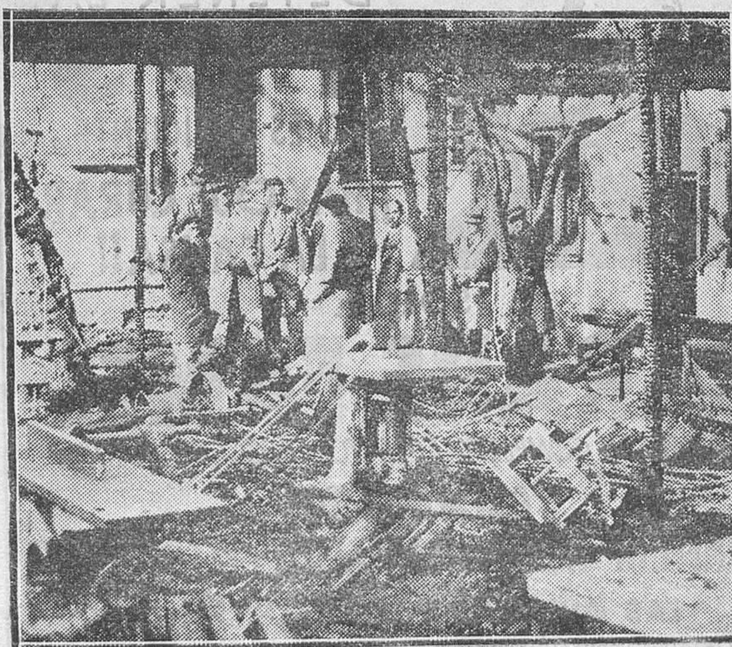
MADRID.—Estado en que quedó la nave principal del taller de ebanistería de la calle Fernández de la Hoz, después del incendio, y cuyas pérdidas ascienden a 200.000 ptas
