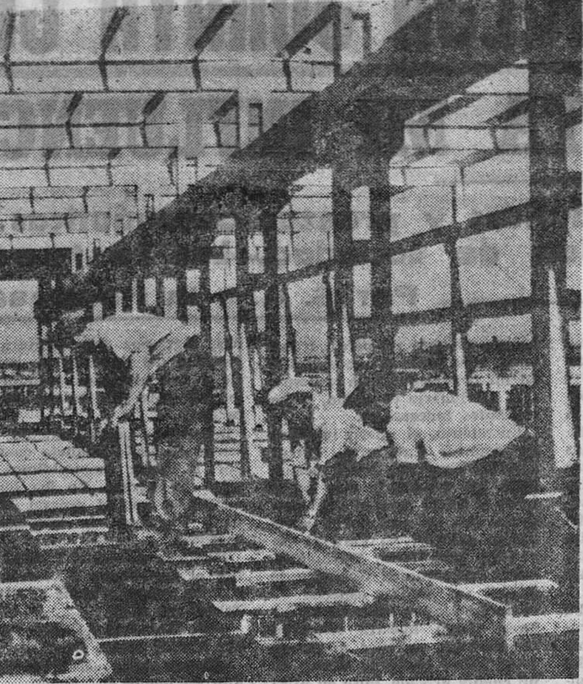
De casas "prefabricadas", naturalmente. Se alza en Munich y construirá anualmente los elementos necesarios para edificar quinientas viviendas. Su infraestructura ha sido también un record, realizada en dos semanas y media.
