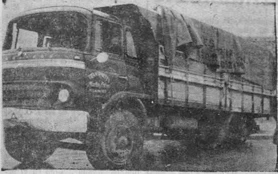
Este es el camión, con el eje trasero desprendido.—(Foto Trabanca.)
