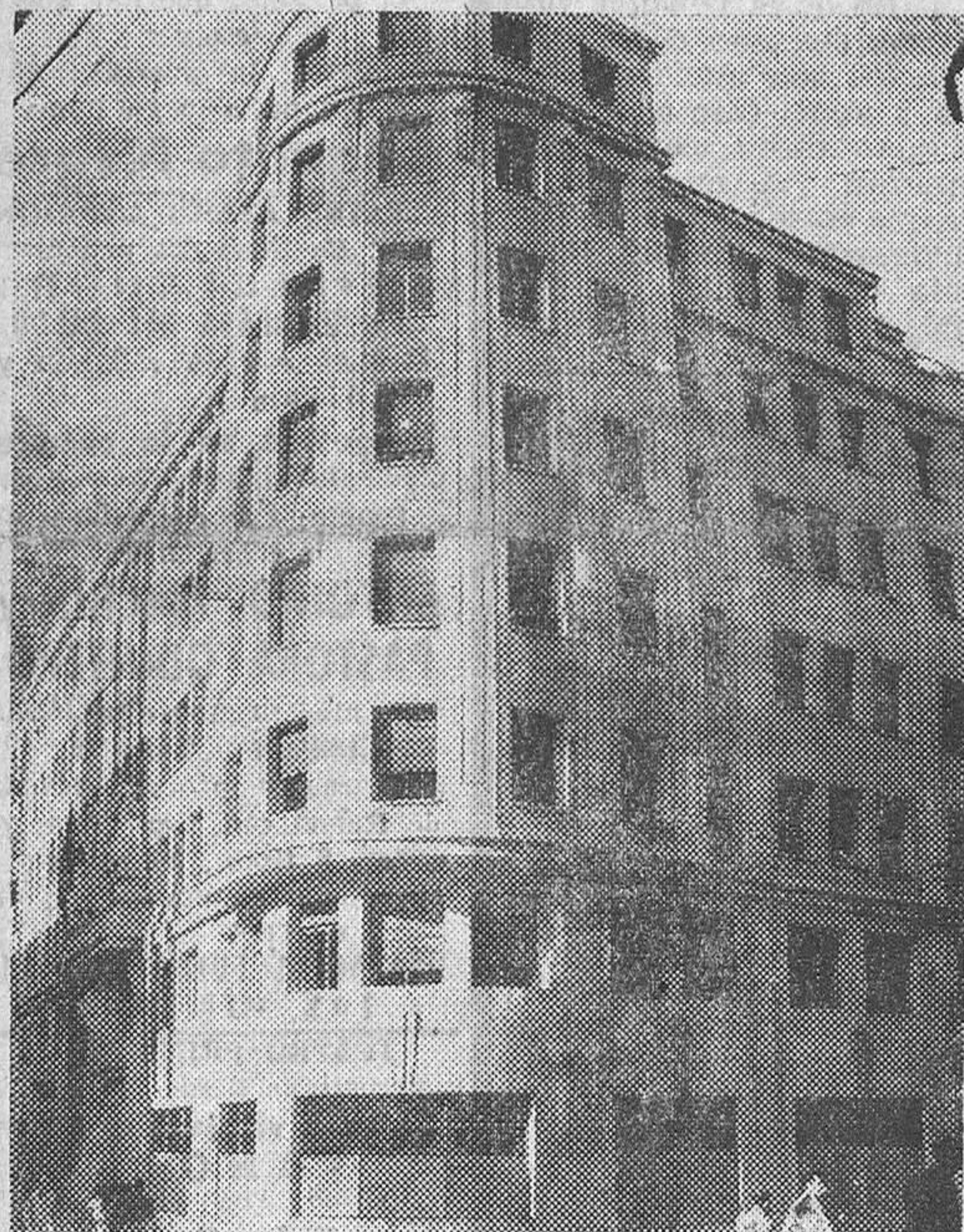
Este es el magnífico edificio de nueva planta propiedad de la C.N.S. de Santander, en el que han quedado instalados los servicios de la Organización Sindical montañesa, y que ha inaugurado recientemente el delegado nacional de Sindicatos.
