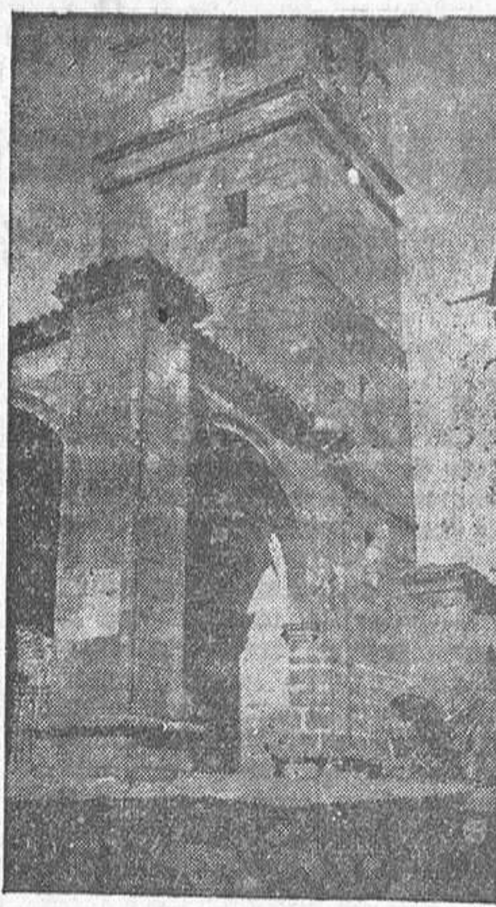
Torre de la iglesia parroquial de Fermoselle (Foto BERNARDO)
