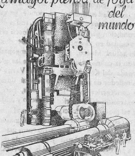
de una presión de 15.000.000 de kilos, fué construida por WAGNER & Co. de Dortmund, según planos de construcción de ADOLF KREUSER. Esta máquina gigantesca tiene 38,5 m. de longitud y 13,7 m. de altura, y es capaz de forjar cilindros de hasta 300.000 kilos de peso.
