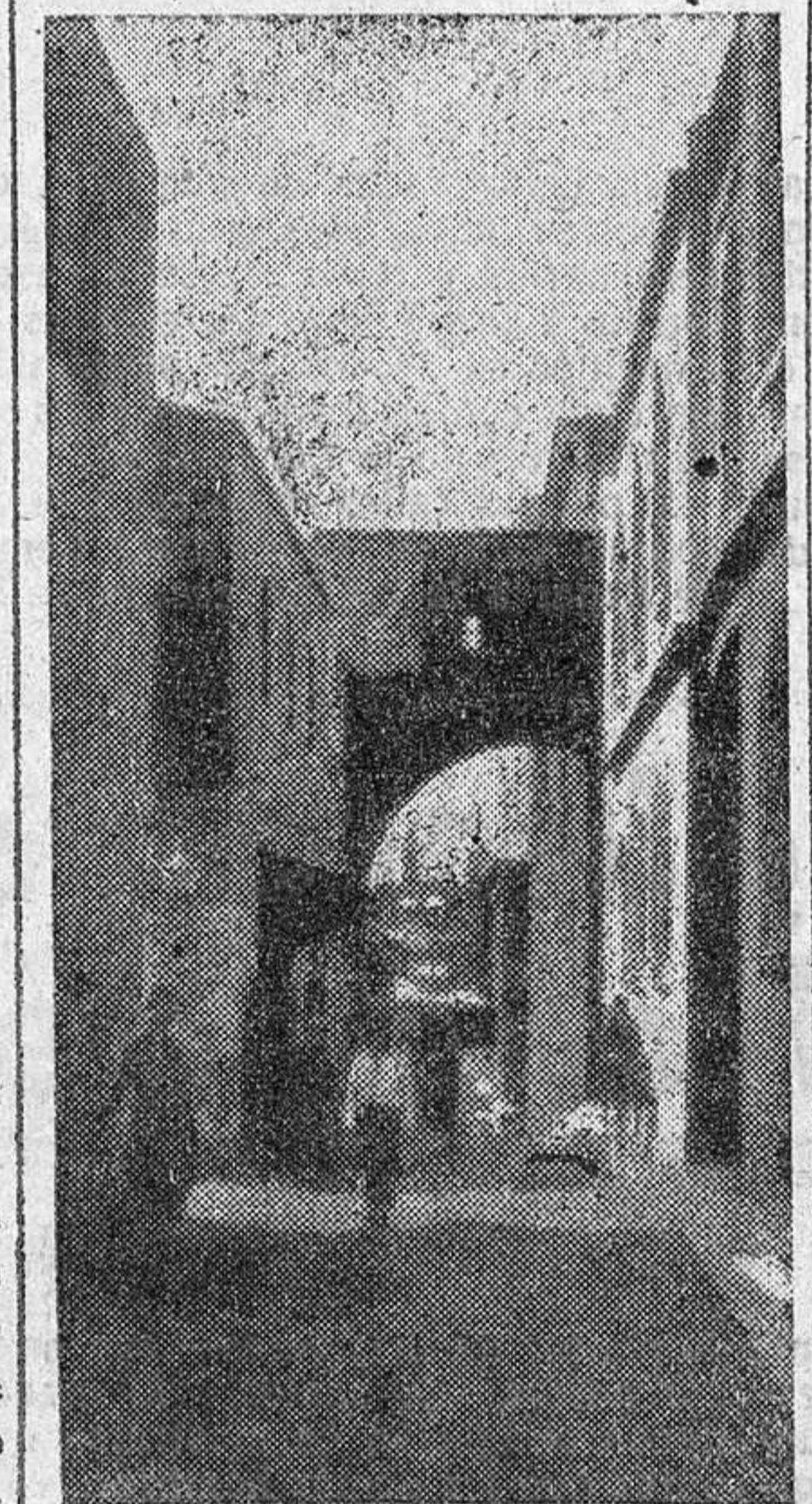
El Arco del Ecce-Homo y principio de la calle de la Amargura.
