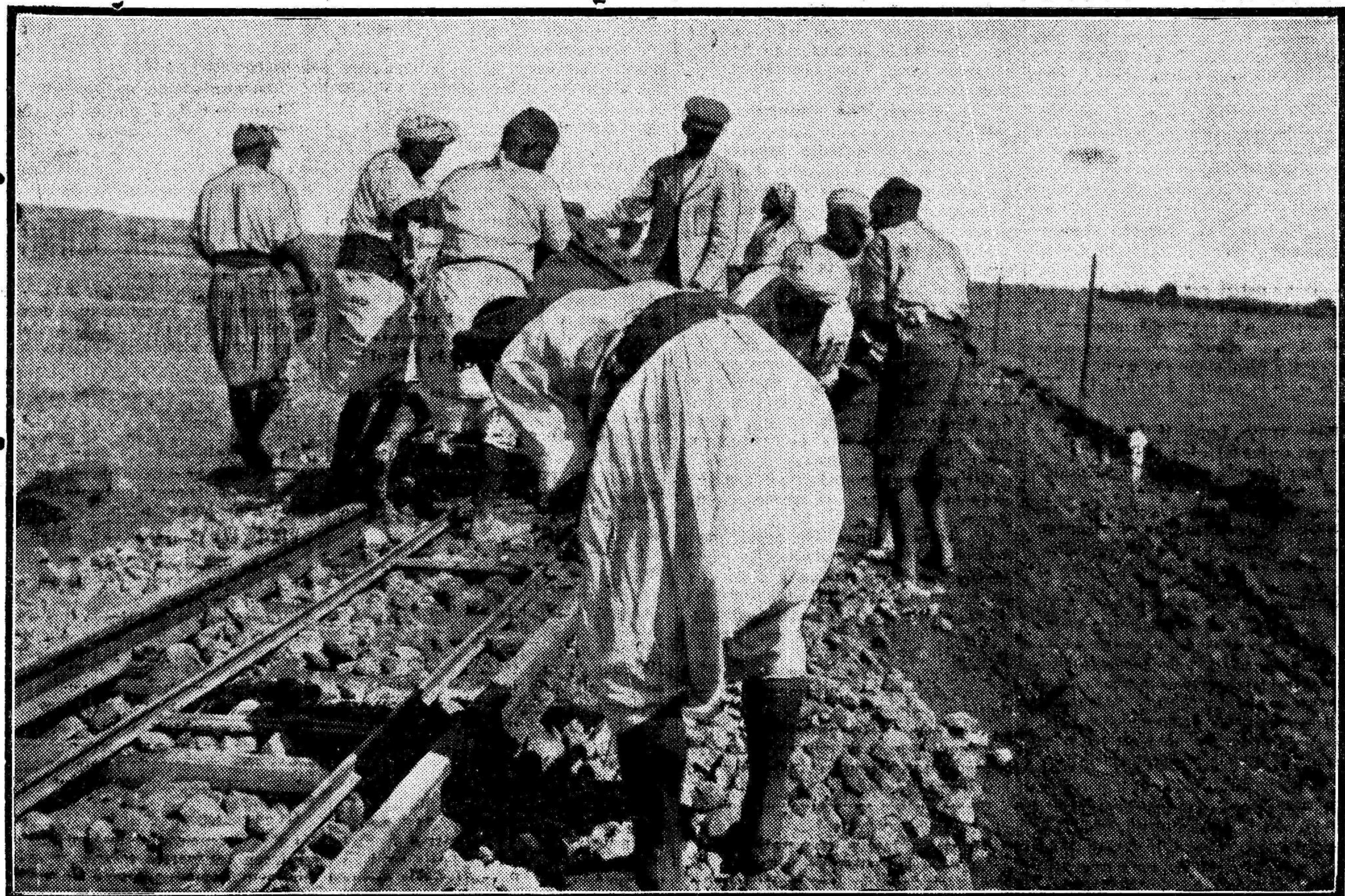
Moros trabajando en la construcción de la vía del ferrocarril minero español en el trayecto de la tercera caseta a Nador
