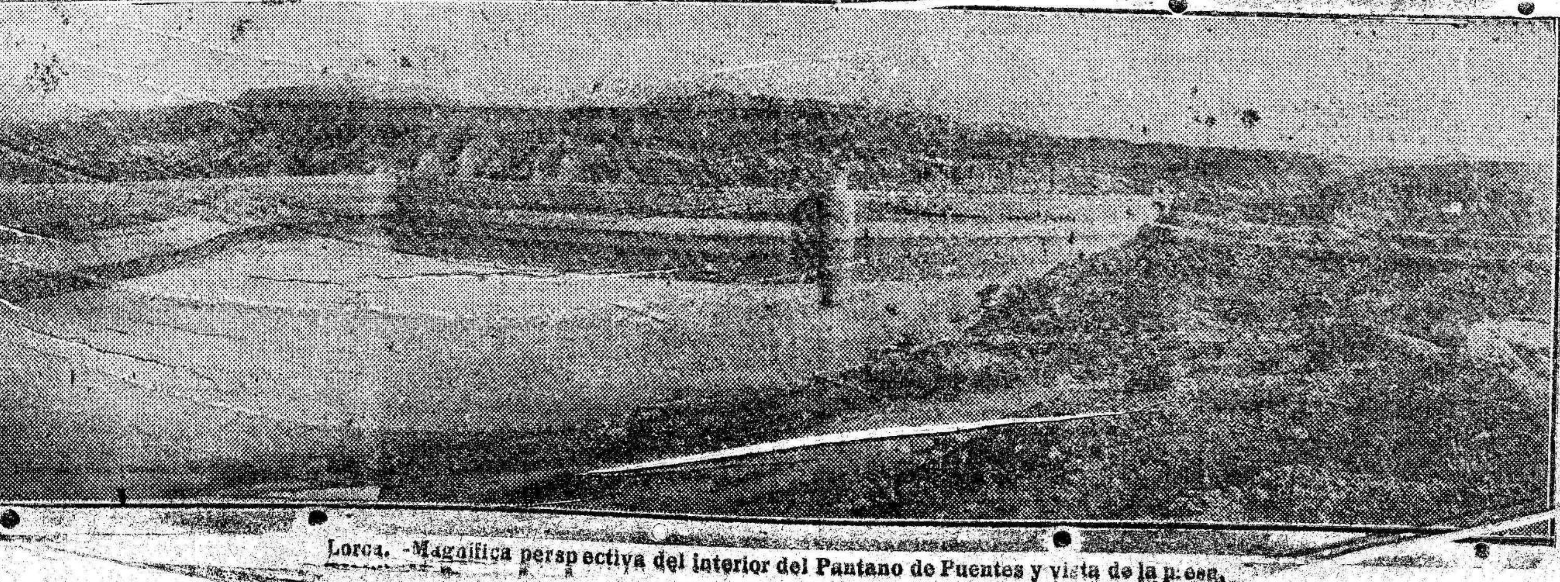
Lorca. Magnífica perspectiva del interior del Pantano de Puentes y vista de la presa.
