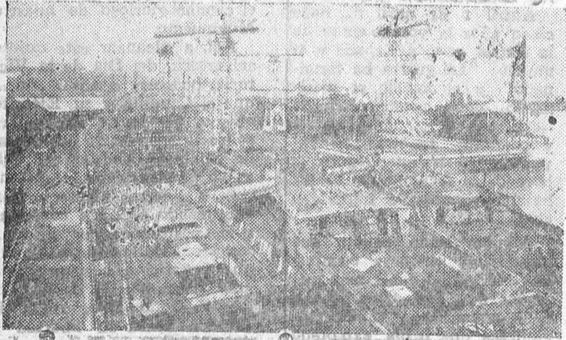
En la factoría de Sestao, cuya vista parcial ofrecemos en esta fotografía, se trabaja en la construcción simultánea de varios buques bacaladeros.
