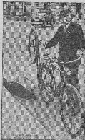
Un ingeniero en Hamburgo ha construido esta bicicleta, con una tercera rueda y un sidecar desmontables mediante un sencillo mecanismo.
