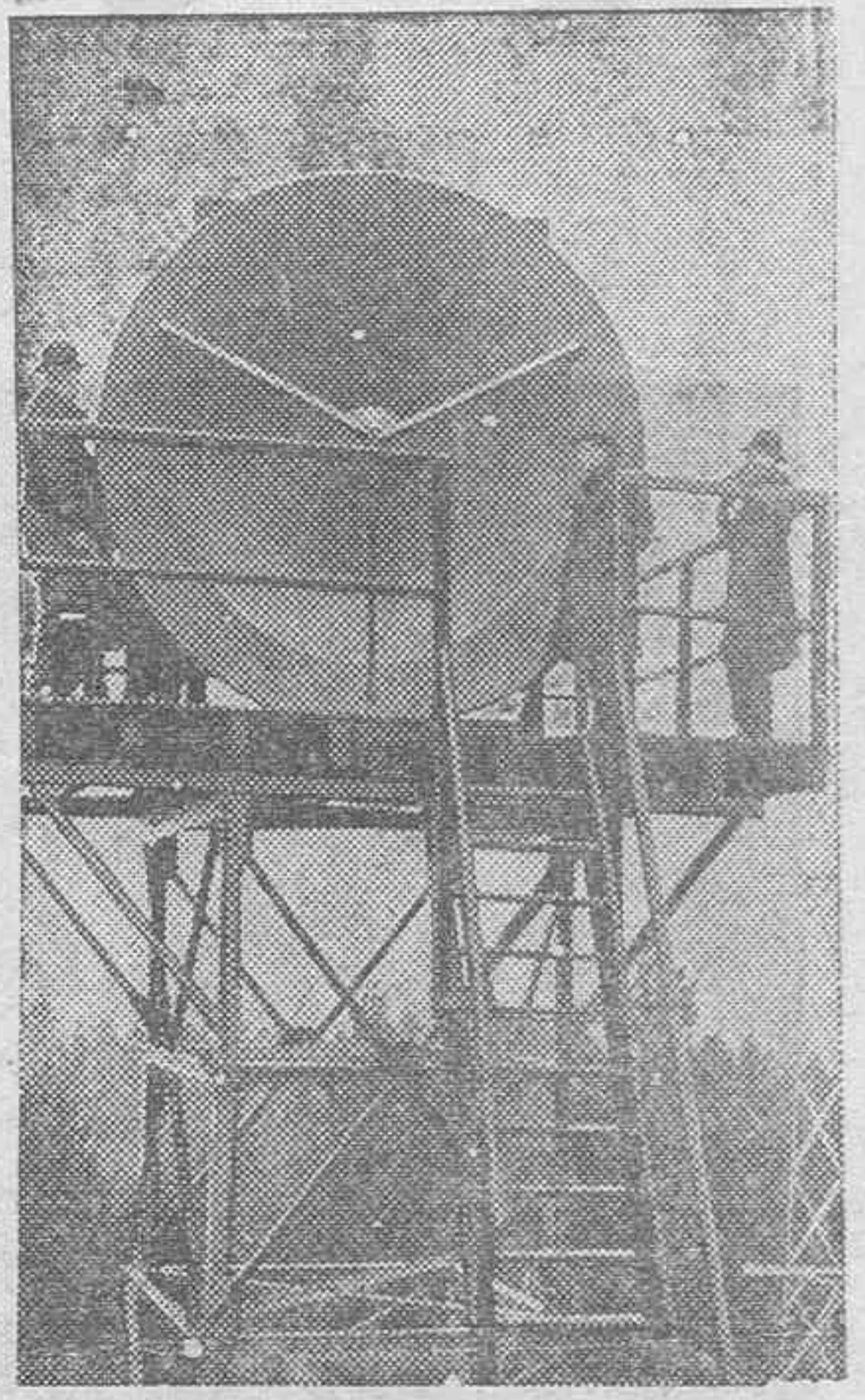
El nuevo sistema de altavoces instalados entre la estación de Lym-pue (Inglaterra) y el aeródromo de St. Inglevert (Francia) para el servicio de tráfico aéreo comercial a través de la Mancha.
