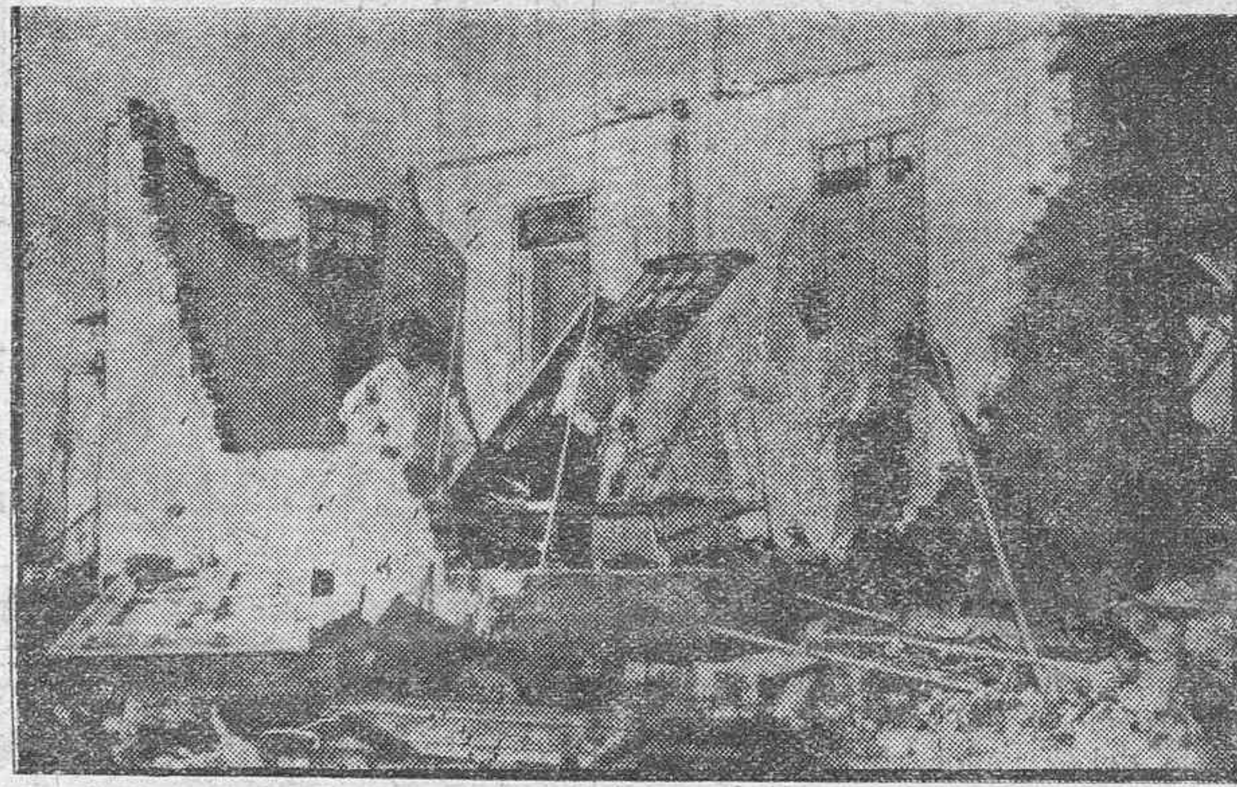
Casa destinada a cocina y alojamiento de los enfermos del pabellón C. R. Alemán, de la Asociación Canaria de la Habana, que fué destruida por el ciclón.—Una vista de los pabellones de tuberculosos de la Asociación Canaria, que también sufrieron grandes destrozos. En dichos pabellones se albergaban 29 enfermos y cinco sirvientes, resultando muerto uno de ellos, llamado Andrés Breijo.
