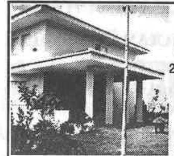
Chalet MIRADOR DE ARANJUEZ 221 mts. construidos Salón ampliable hasta 41,54 m. 4 dormitorios, despacho, calefacción. gasoil 2 baños y aseo
