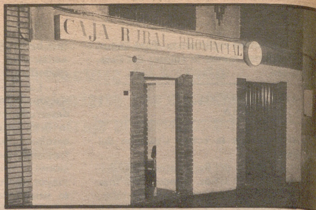
Fachada de la nueva sucursal de la Caja Rural de Aguarón.
