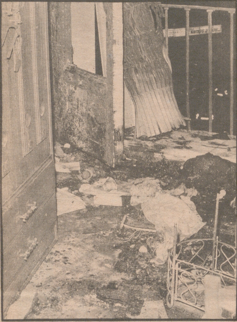
Estado en que quedó el piso de don Luis Buil, tras incendiarse después de haber penetrado por el balcón una bomba de humo. (Foto, García Luna.)
