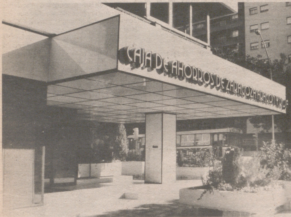
Fachada principal de la nueva oficina.
