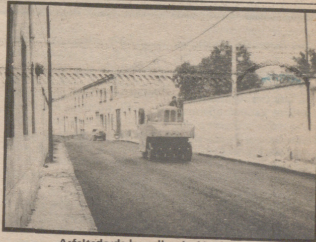
Asfaltado de las calles de Alagón
