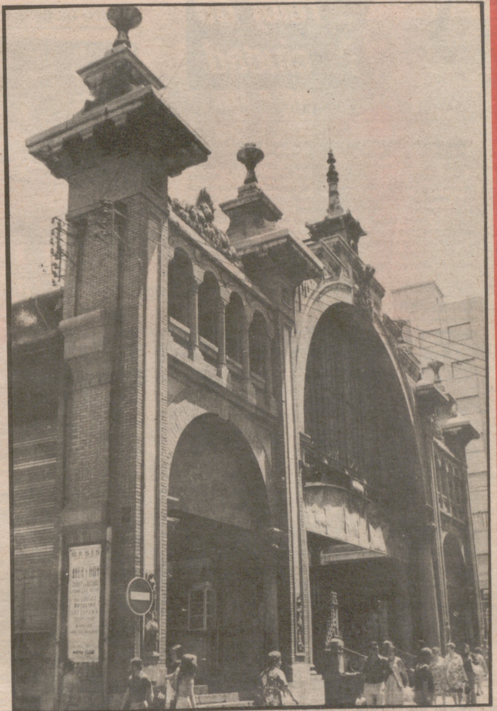
El Mercado, construido en 1903, es una de las mejores obras modernistas de la ciudad. Parece que será destinado a Jardín Botánico, aunque no faltarían soluciones mejores. Y el problema de los concesionarios sigue sin resolver.
