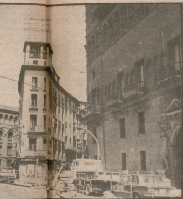
En Escuelas Pías, el saneamiento ha actuado por expropiación. En los Escolapios, actuado por la compra.
