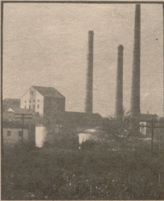
Unas factorías, como ésta de Epila que reproduce la foto, fueron cerradas para que el tiempo consumiera su obra destructora. Otras —Casetas, Gallur, Zaragoza— fueron arrasadas y dinamitadas sus arosas chimeneas. Con aquellas voladuras se cerró una época. Hoy, si cuajara un auténtico cooperativismo, podría iniciarse otra más afortunada para nuestros remolacheros.
