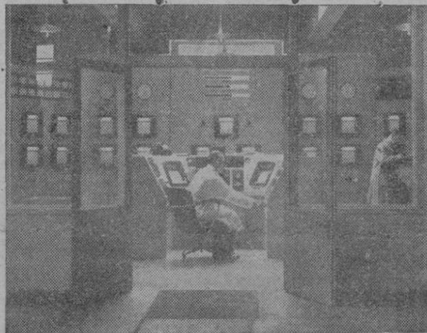
Cabina de control de la pila atómica de Harwell. El técnico, desde su mesa, puede regular la temperatura en los distintos puntos de la pila, variar las corrientes de aire, etc.
