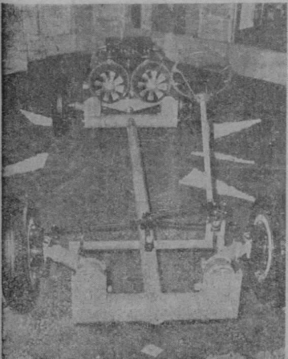
Este es el chasis del «Symetric», el coche francés sin embrague con un motor eléctrico en cada una de las ruedas
