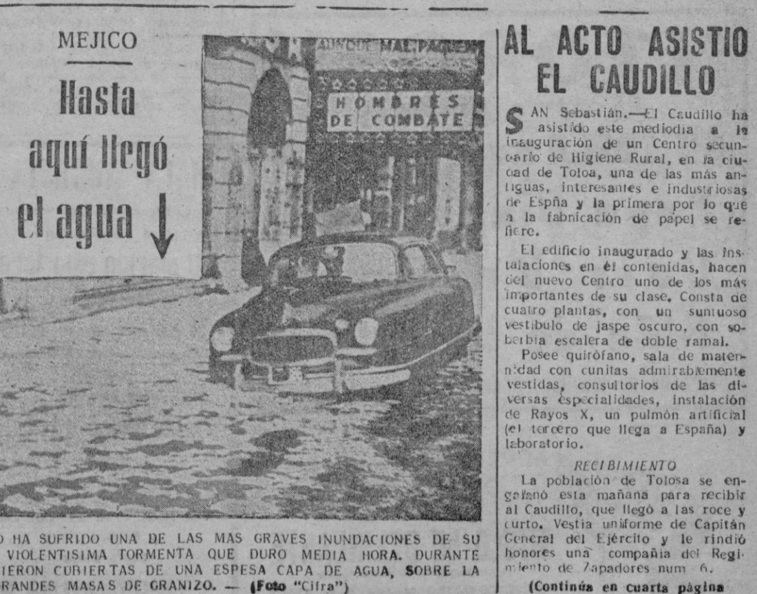
MEJICO. — LA CIUDAD DE MEJICO HA SUFRIDO UNA DE LAS MAS GRAVES INUNDACIONES DE SU HISTORIA A CONSECUENCIA DE UNA VIOLENTISIMA TORMENTA QUE DURO MEDIA HORA. DURANTE MUCHO TIEMPO LAS CALLES ESTUVIERON CUBIERTAS DE UNA ESPESA CAPA DE AGUA, SOBRE LA QUE FLOTABAN GRANDES MASAS DE GRANIZO. — (Foto "Cifra")
