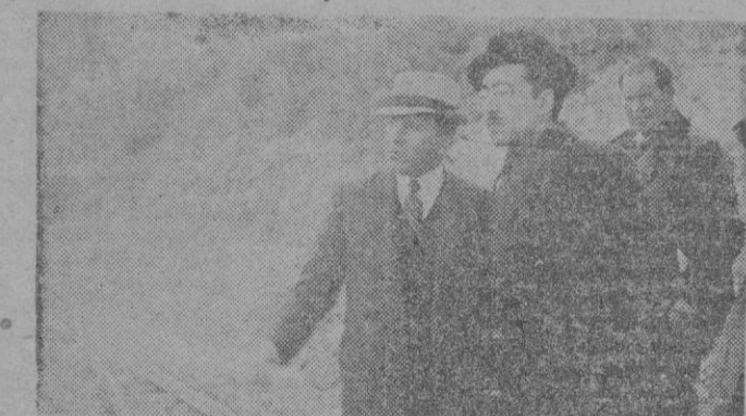
El Excmo. Sr. Gobernador Civil camarada Rodríguez Miguel escuchando las explicaciones que le da el Ingeniero Sr. Ochoa sobre la construcción del ferrocarril.
