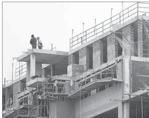
Varios empleados, en la construcción de una vivienda. / LUIS LÓPEZ ARAICO
