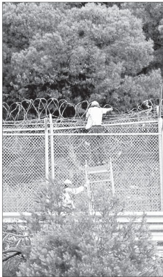
Un operario trataba ayer de reparar parte de la valla fronteriza. /EFE
