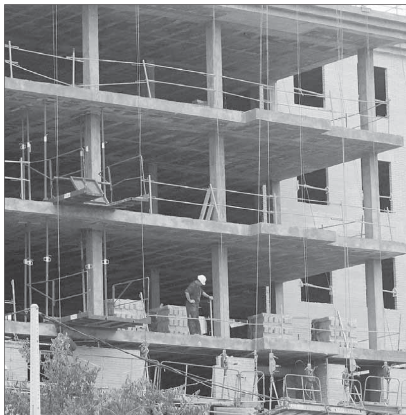
Un inmueble, en pleno proceso de construcción. / ICAI
