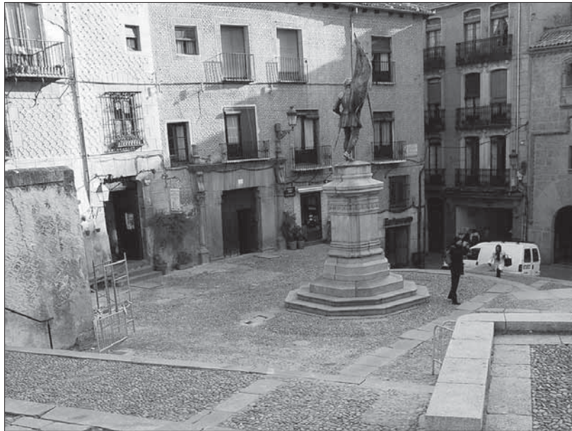
Una de las obras proyectadas es la renovación del pavimento de la Plaza de Medina del Campo PENALOSA
