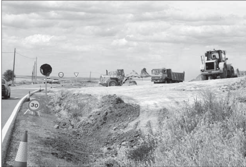
Actualmente se están realizando las obras de la futura autovía, entre la CL-603 y Segovia
