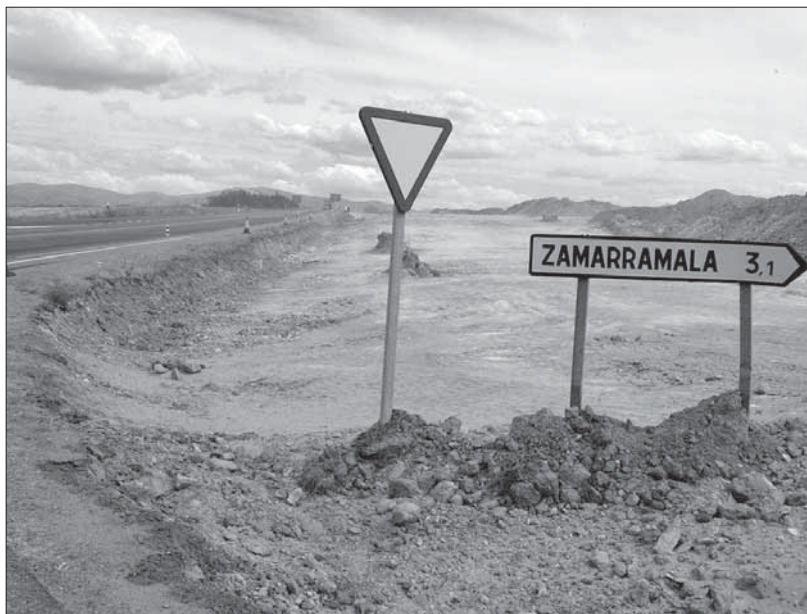
Las obras ya se han iniciado en el tramo de 8,4 kilómetros situado a la salida de Segovia FERNANDO PEÑALOSA
