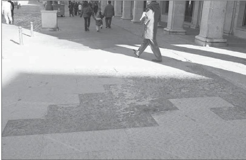
El pavimento deteriorado se corresponde con el tramo de la avenida que tiene losas finas
