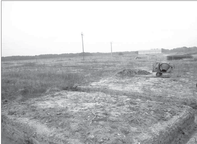
Estado actual de las obras de estas quince viviendas sociales
