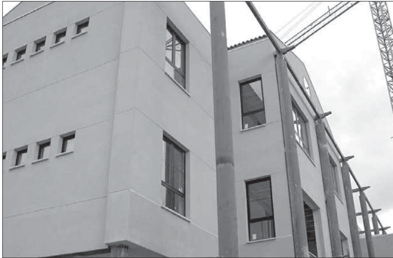
Las obras del nuevo Consistorio estarán concluidas en enero de 2005
