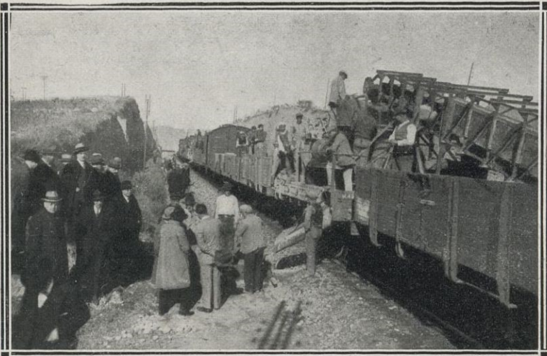
Trabajos de electrificación del ferrocarril de Barcelona a Manresa
