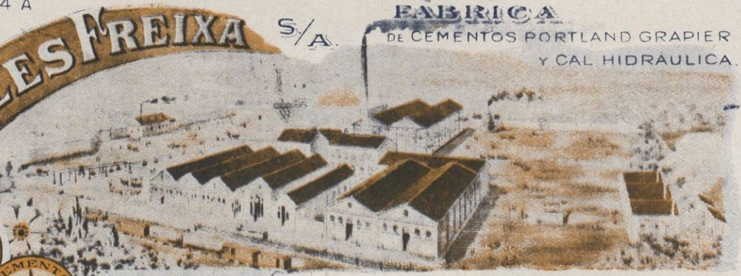
VISTA DE LA FABRICA DE MONJOS CERCA VILLALBA DE CANALS
