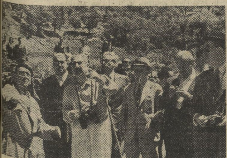
El ministro, rodeado de los ingenieros, espera la voladura de una montaña en la presa de Escales
