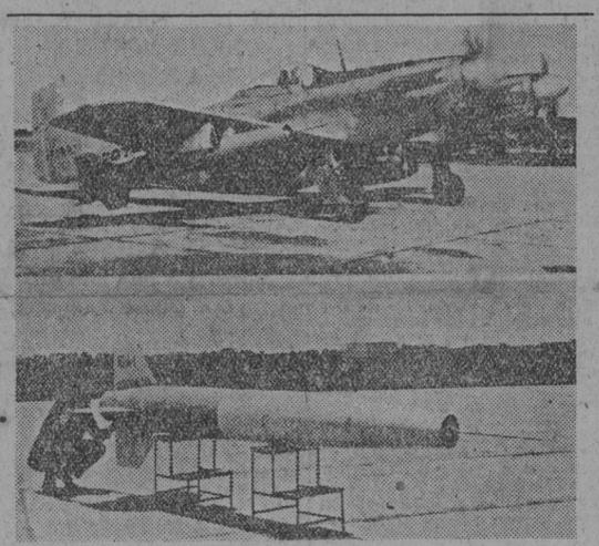
Con este cohete de retropropulsión (foto inferior) se obtuvieron 1.600 millas por hora en unas recientes pruebas en Cleveland, lo que representa dos veces la velocidad del sonido. En la foto superior vemos el cohete montado sobre un avión de caza «F-52», que le subió hasta la altura que se creyó conveniente, desde donde le soltó imprimiéndole la velocidad supersónica mencionada. — (Foto Ortiz)
