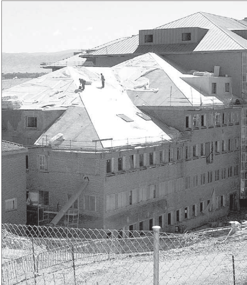
Las obras han traído la polémica entre el Sacyl y los representantes sindicales
