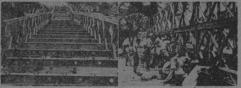
Las fotografías muestran dos momentos de la construcción por los zapadores del ejército británico de Birmania, de un puente sobre el canal de Pegu, destinado al paso de las fuerzas blindadas del SO. del Pacífico. La construcción de este puente se efectuó en tres días de trabajos incesantes y en medio de un terrible monzón. (Foto Crown.)
