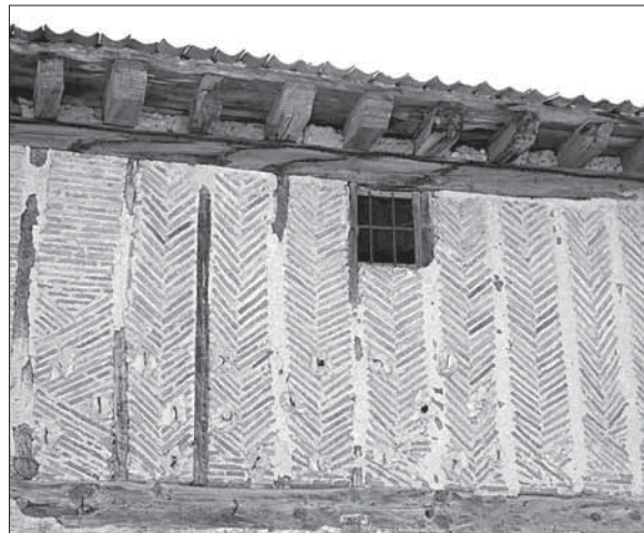
Construcción de ladrillo, adobe y madera
