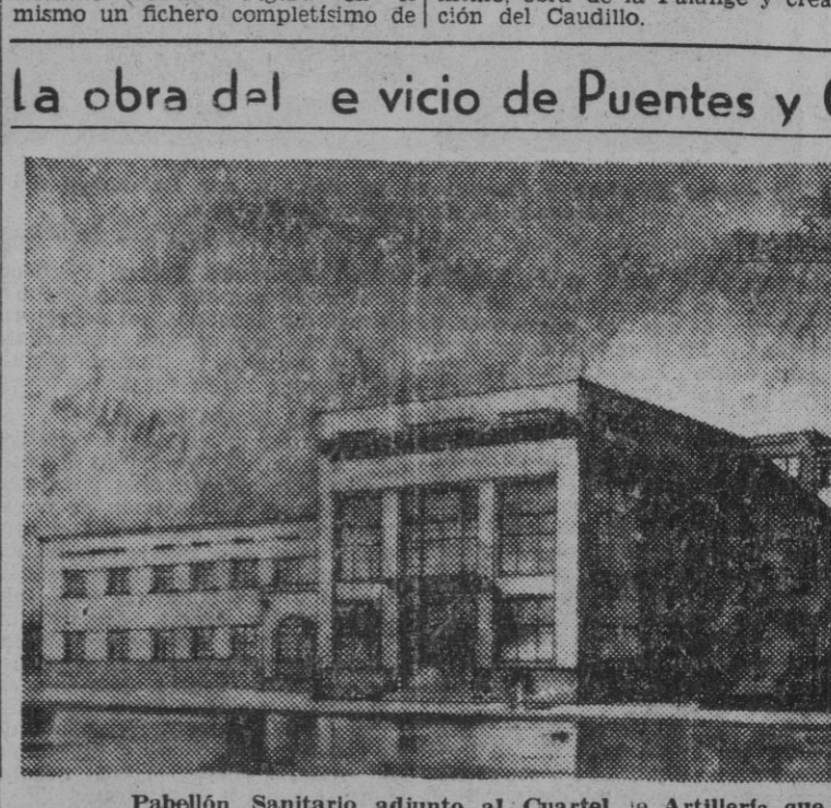
Pabellón Sanitario adjunto al Cuartel de Artillería que se construye en Lérida
