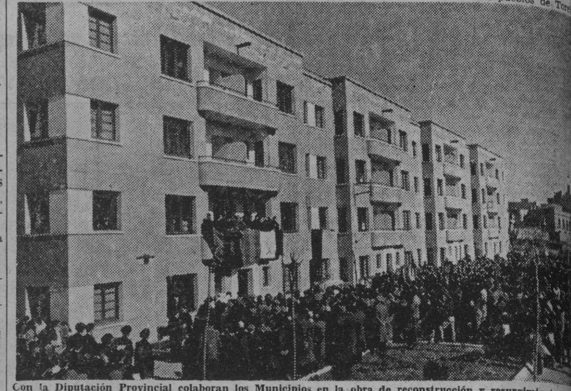
Con la Diputación Provincial colaboran los Municipios en la obra de reconstrucción y resurgimiento. Estos edificios conocidos por el "Bloque del Caudillo", que ha levantado en la Torrassa el Ayuntamiento de Hospitalet de Llobregat.
