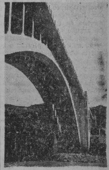
Detalle del Puente de José Antonio
