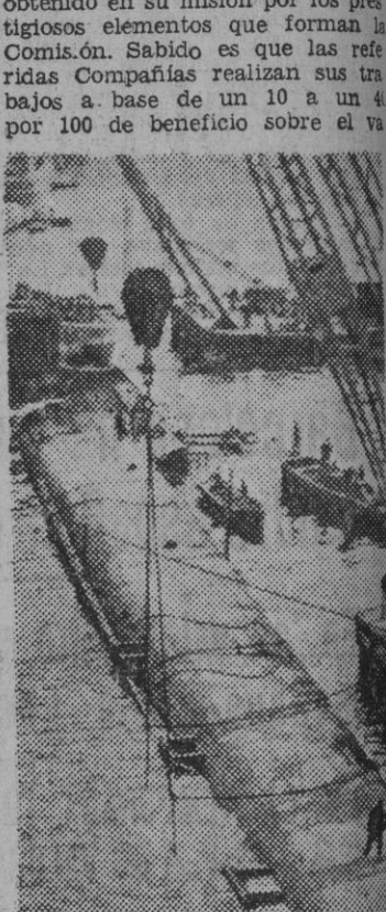
Con aire comprimido, dos cabrias y dos barcasas se levantó el "Ciscar", el fondo y se le trasladó tumbado hasta colocarlo sobre una cama. (Foto Cifra)
