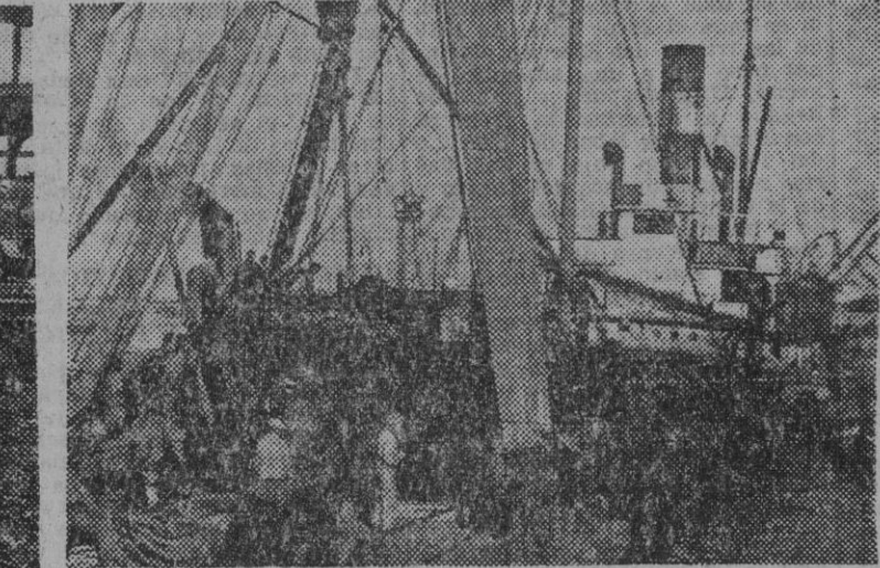
Salvamento de buques en el Puerto de Barcelona. A la izquierda, aspecto del Puerto al ser liberada la ciudad. — A la derecha, trabajos de salvamento de buques y aspecto de los muelles en la actualidad. — (Fotos Pérez de Rozas)
