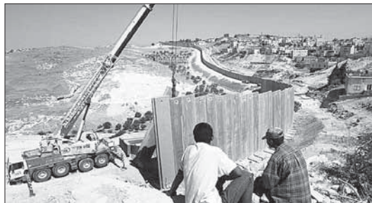
Dos palestinos observan los trabajos de construcción del muro. / L. PITRAKIS (AP)
