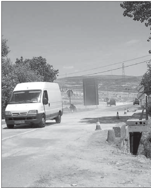
Imagen del puente, una vez acabadas las obras
