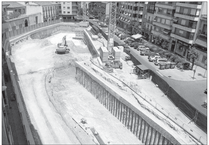
La empresa adjudicataria de las obras del parking ya ha iniciado los trabajos de excavación
