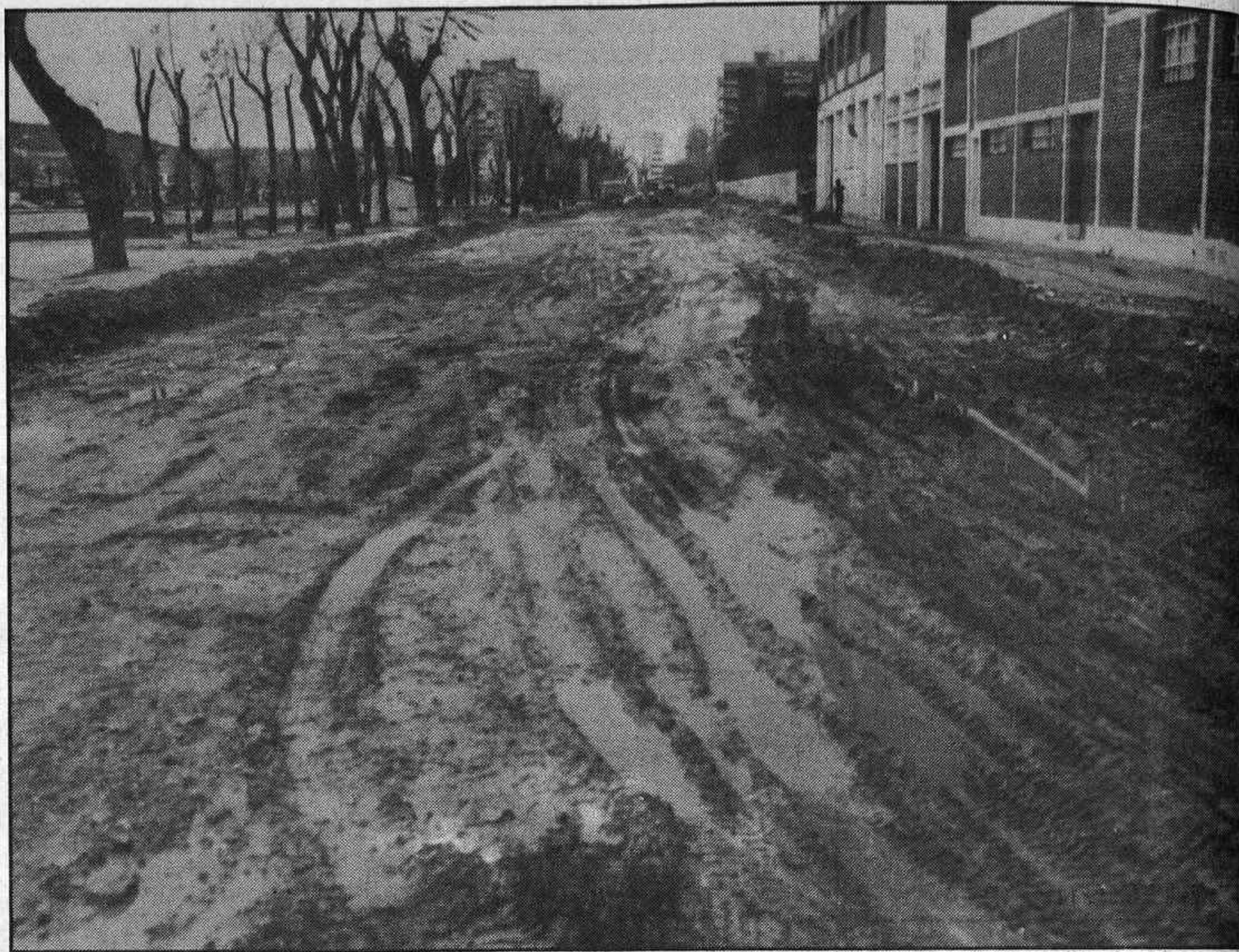
Todavía existen muchas calles en los barrios extremos que carecen de pavimentación, y cuando llueve se convierten en barrizales.
